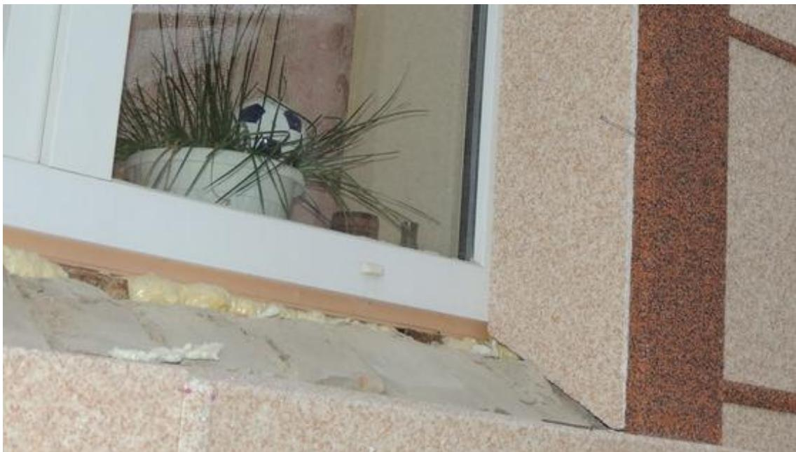
Рис. 4.8 Монтаж декоративного обрамления и накладки на откос
