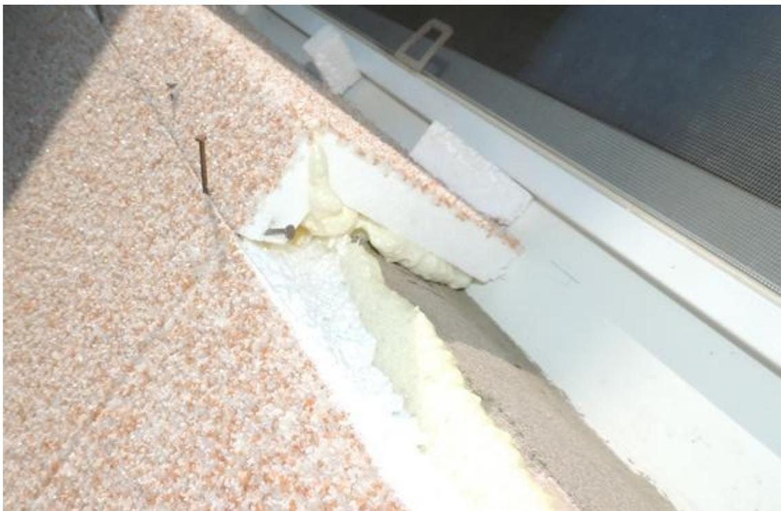
Рис. 4.6 Утепление откоса угловым элементом
