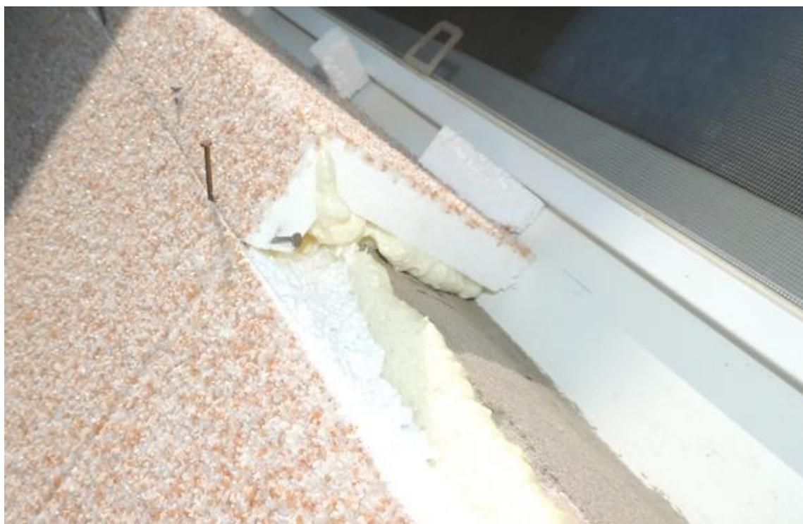
Рис. 4.6 Утепление откоса угловым элементом
