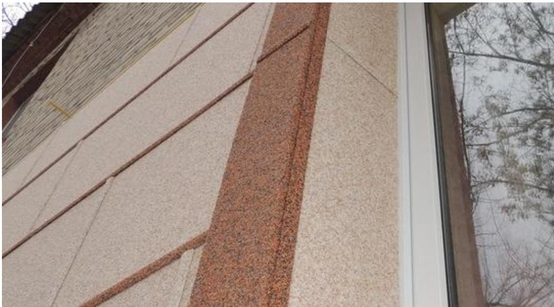
Рис. 4.9 Закрытие швов откоса т-образной декоративной планкой
