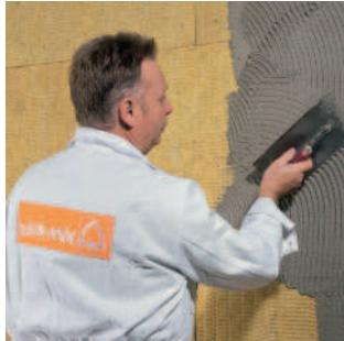
На теплоизоляционные плиты, в данном случае – минераловатные, приклеенные Клеящим раствором для керамической плитки RKS, наносят первый слой армирующего раствора RAS толщиной ~ 5 мм. В него с помощью гладилки вдавливается утолщенная Армирующая сетка PUG.
