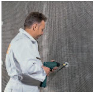
Затем через армирующую сетку PUG плиты крепят тарельчатыми дюбелями LOBATHERM и головки дюбелей шпаклюют RAS способом «мокрое по мокрому». Минимальная общая толщина армирующая слоя составляет 7 мм.
