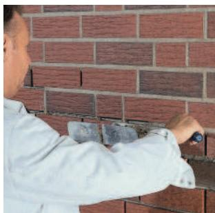
Швы открытопористых плиток заделывают Раствором для заполнения швов RFS с помощью расшивкой и ...
