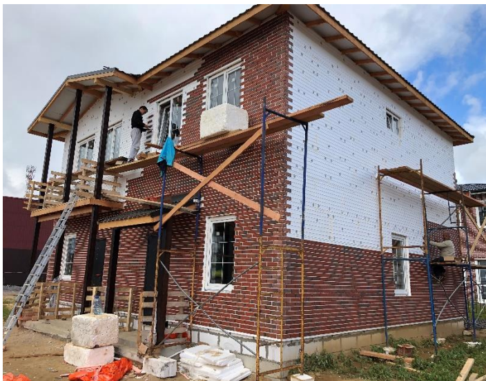
3. Монтаж клинкерной плитки
